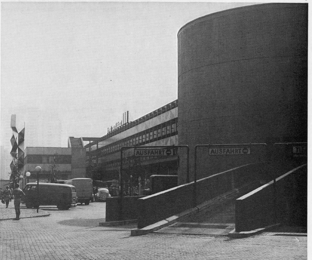
6 Südlicher Seitentrakt mit Anlieferungsrampe. Fassade Betonfertigteileplatten; Fenster oben in Holz, unten in Stahl, rot und olivgrün gestrichen. 7 Brücke in der Ladenstraße. 8 Treppenhautür an einer Verbindungsbrücke. 9 Blick von der westlichen Auffahrtsspindel auf die Nordfront am Marktplatz; links Edelstahlbrunnen von Bildhauer Hölzinger
